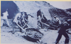
党中央机关北迁延南，习仲勋先期到达马栏，住在东村农家，上山/下溪勘察地形，随后带领干部战士自己动手挖窑洞，半年时间在马栏西河坡挖了200多孔窑洞，解决了办公住宿问题。
