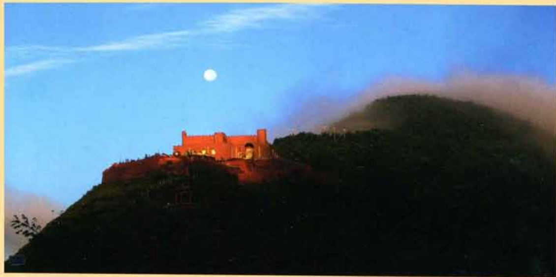
修复后的旦八寨子
